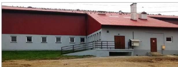
Przykładowy budynek inwentarski w Jaworzu-Jasienicy, Polska.
