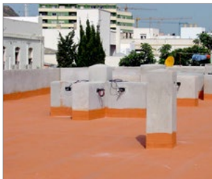
Hiszpania: budynek mieszkalny w miejscowości Vera
